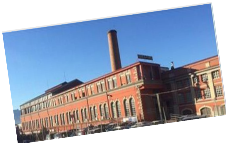
Istituto Tecnico Industriale "E. Fermi"
