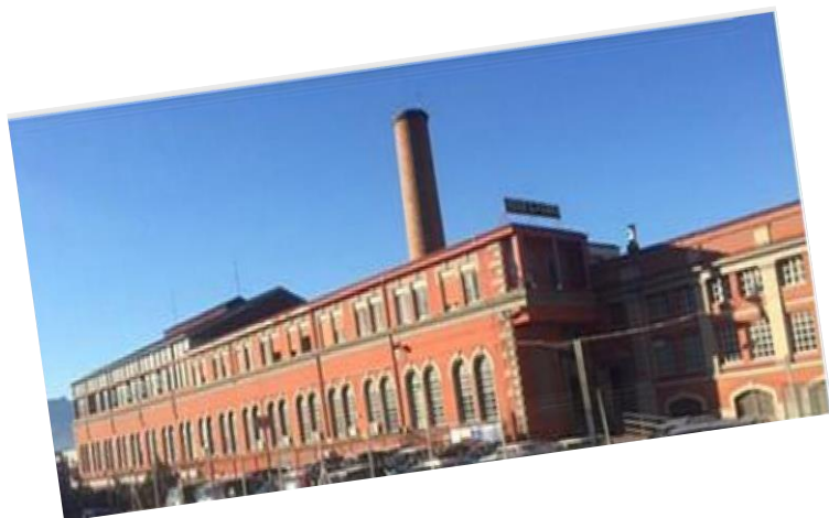
Istituto Tecnico Industriale “E. Fermi”
